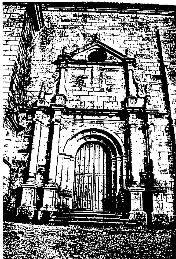
Fachada principal de la iglesia
